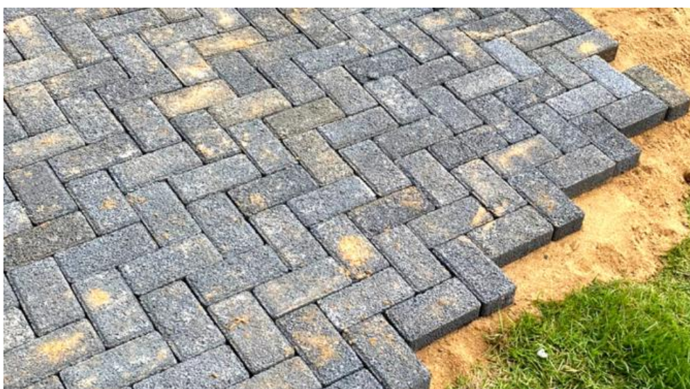
Figura 02: Detalhe de pavimento intertravado (paver), solução que alia durabilidade e permeabilidade do solo.
